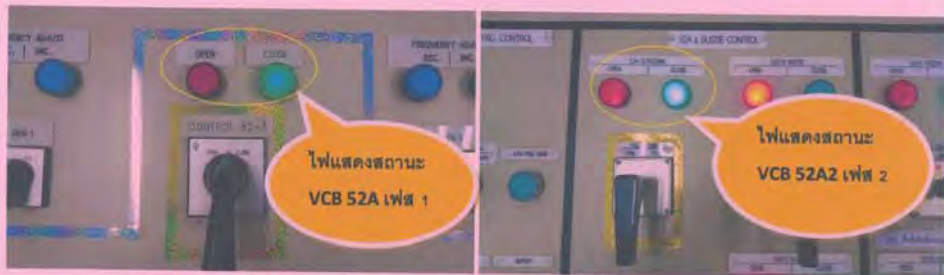
รูปที่ 2 แสดงสถานะ VCB 52A และ VCB 52A2 ที่ Control desk
